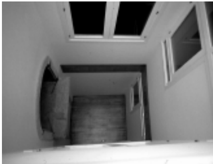
A creación dun patio de luces, aínda que sexa pequeno, mellorará as condicións de habitabilidade das vivendas. Patio de ventilación en edificio da Rúa do Franco.
