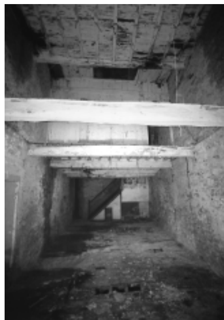
Estructura tradicional de madeira entre muros medianeiros. Edificio en Rúa de San Pedro.
