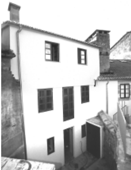
Edificio en Campo de San Antonio. Estado actual.
