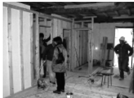
Instalación de tabiquerías lixeiras en Fonte de San Miguel.
